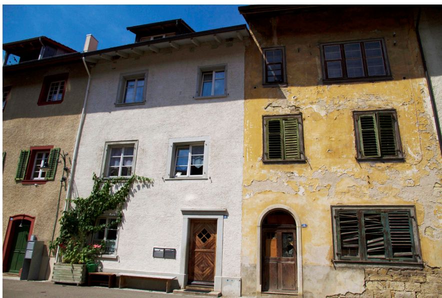
Abb. 46: Alte Bausubstanzen mitten im Ortskern von Neunkirch. Foto: Esther Frey.
